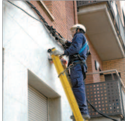
Un dels operaris de la companyia reparant l'avaria
